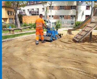
Sandreinigung, Belüftung bis zu 20 cm Tiefe
